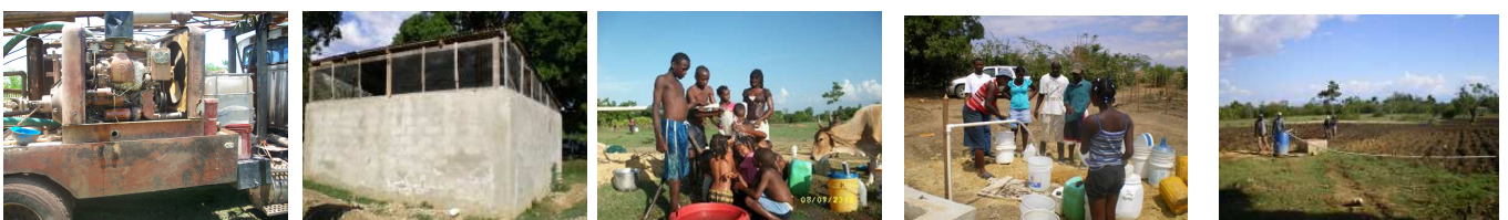
Savane Laboue. Plateau Central. 1 Forage pour l'eau potable et l'irrigation. 2. Bassin de retenue d'eau pour irrigation. 3. 4. Eau potable pour 600 personnes.(Savane Laboue) 5. Mise en valeur des terres pour les paysans pauvres, pépinière pour cultures vivrières, arbres fruitiers et forestiers pour reboisement.
