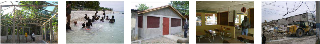
1. Construction d’un poulailler. Ecole Dumarsais, Verrettes. 2. Sortie plage, pour la seconde fois de leur vie, 100 enfants déshérités de Cité Soleil. et Verrettes.3. Construction Ecole Samaritain. Ouanaminthe. 4. Salles de classe Ecole Samaritain. 5. Reconstruction Ecole Sacré Cœur. P. au Prince.
