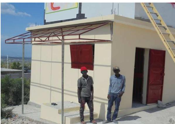
Ci-contre : les bâtiments crépis et peints. Un auvent métallique est posé ; il sera recouvert de tôles de couleur. La plateforme a été montée, en blocs, avec un escalier menant à la fenêtre de vente d'eau. Le peintre en lettres a commencé le travail de décoration sur la citerne, sur quatre côtés. Ci-dessous les images de la décoration.
