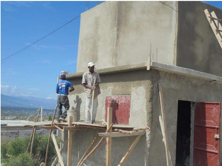
Dernière semaine. Les crépissages sont achevés pendant que la dalle supérieure sèche. Le volets et grilles de sécurité en fer sont posés, ainsi que les portes et la trappe supérieur du réservoir.. L'ensemble sera bientôt peint. Ci-contre : le bâtiment vu de devant. Ci-dessous : vue de derrière.
